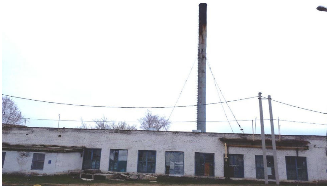
Рис 2 – Централизованная котельная ЦРБ (по адресу г. Калач-на-Дону, ул. Кирова, 172а) Зона теплоснабжения в границах ул. Кирова, ул. Маяковского, ул. Пархоменко, ул. Пролетарской, пер. Московский, пер. Волгоградский.
